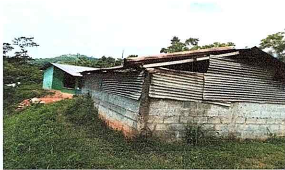
Foto 3: Pared del aula inconclusa cubierta de lamina provisionalmente
